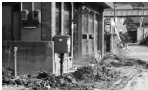
家屋に流れ込んだ大量の土砂…
