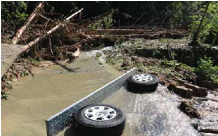
崩れた土砂や倒木で覆われた道路。タイヤも散乱していた＝岡山市 北区栢谷（山陽新聞社提供）
