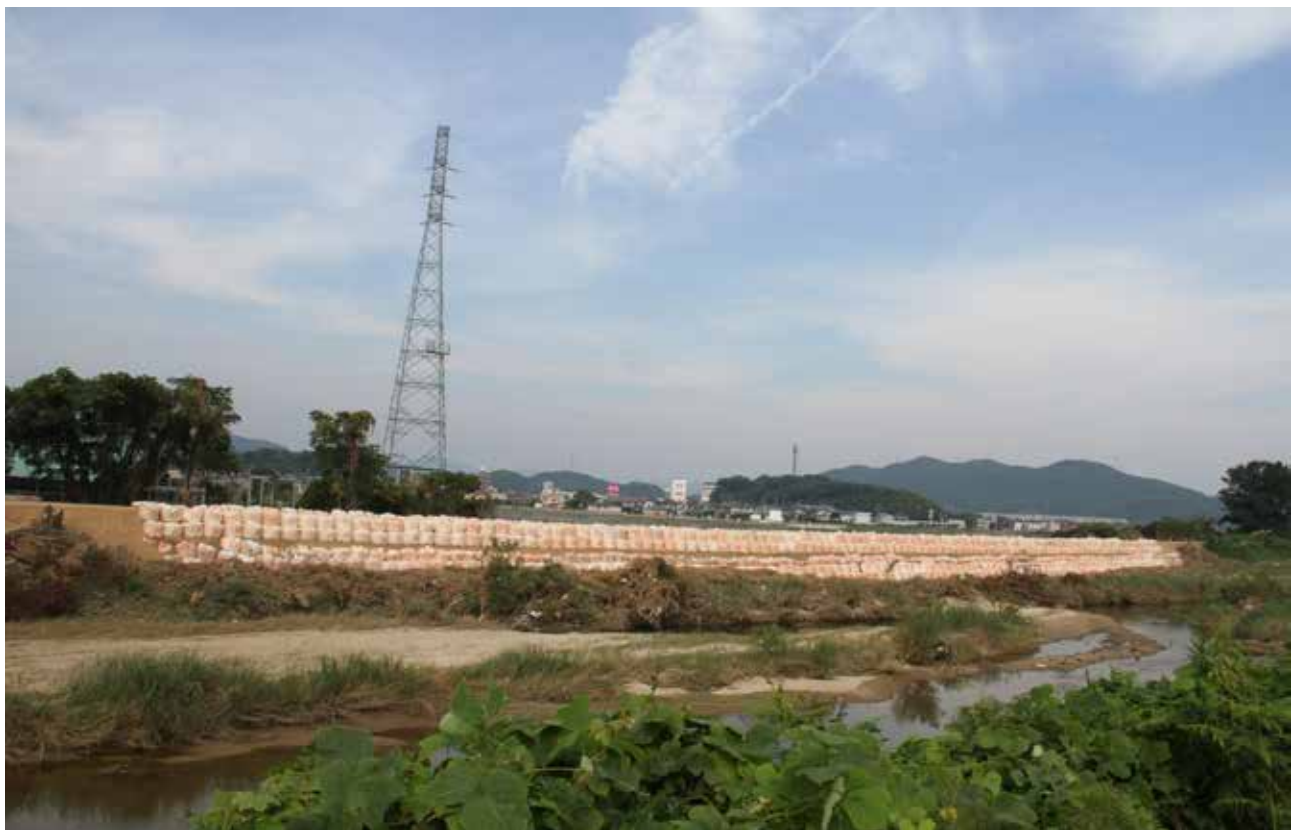
砂川 仮土のう (岡山市広報広聴課提供)
