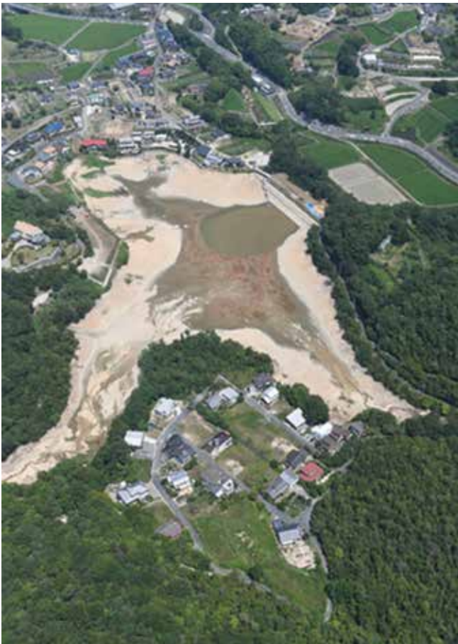
市道の崩落で孤立状態となった菅野地区 (山陽新聞社提供)
